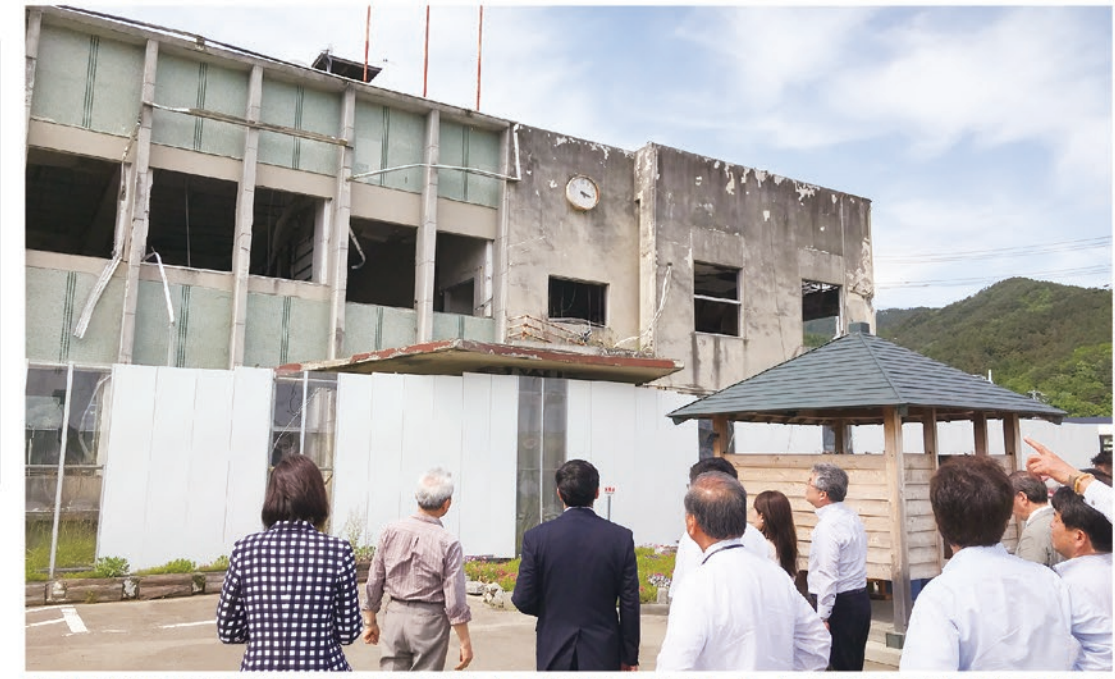
5月に地震津波対策議員連盟で岩手県内の被災地を視察しました。町長ら多数の職員が亡くなった大槌町では、当時の災害対策本部の設置場所に教訓が残っています。
